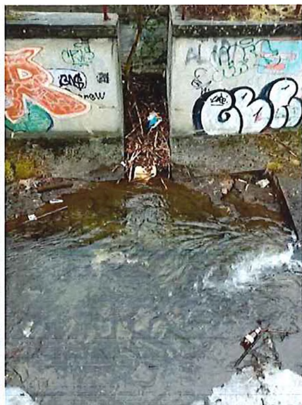
Koryto naplnené nánosmi drevín – nutnosť vyčistiť
