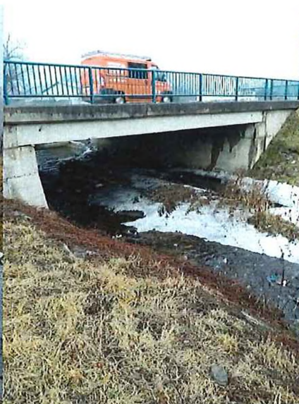
koryto naplnené nánosmi – nutnosť vyčistenia
