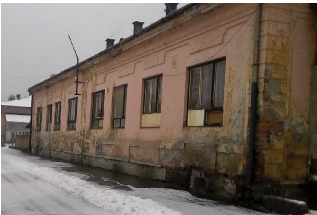
Rožňavská Baňa č. 175 (spolu 7 bytov)
