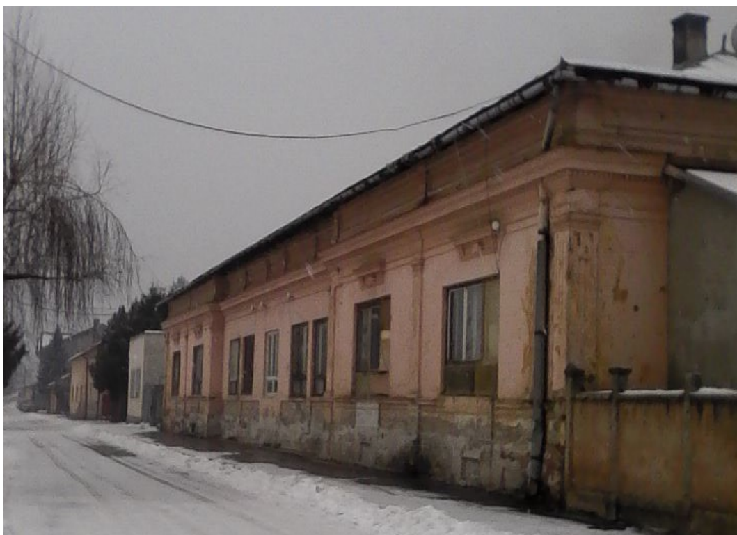
Rožňavská Baňa č. 173 (spolu 14 bytov)
