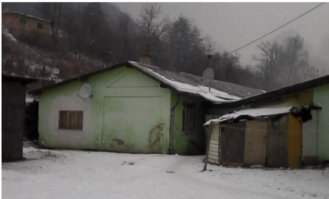
Rožňavská Baňa č. 176 (spolu 2 byty)
