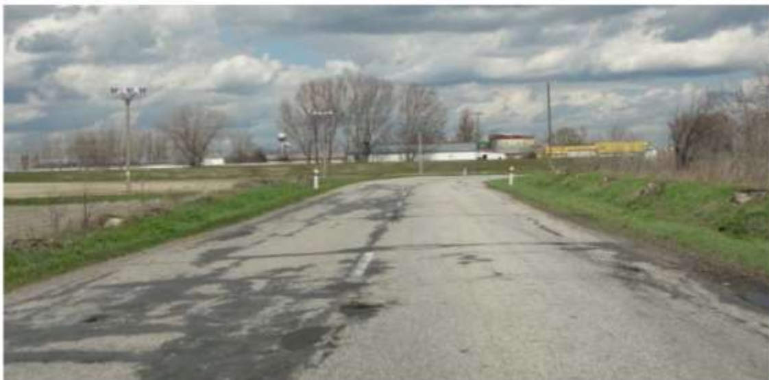
Klasifikačný stupeň 5 – havarijný
