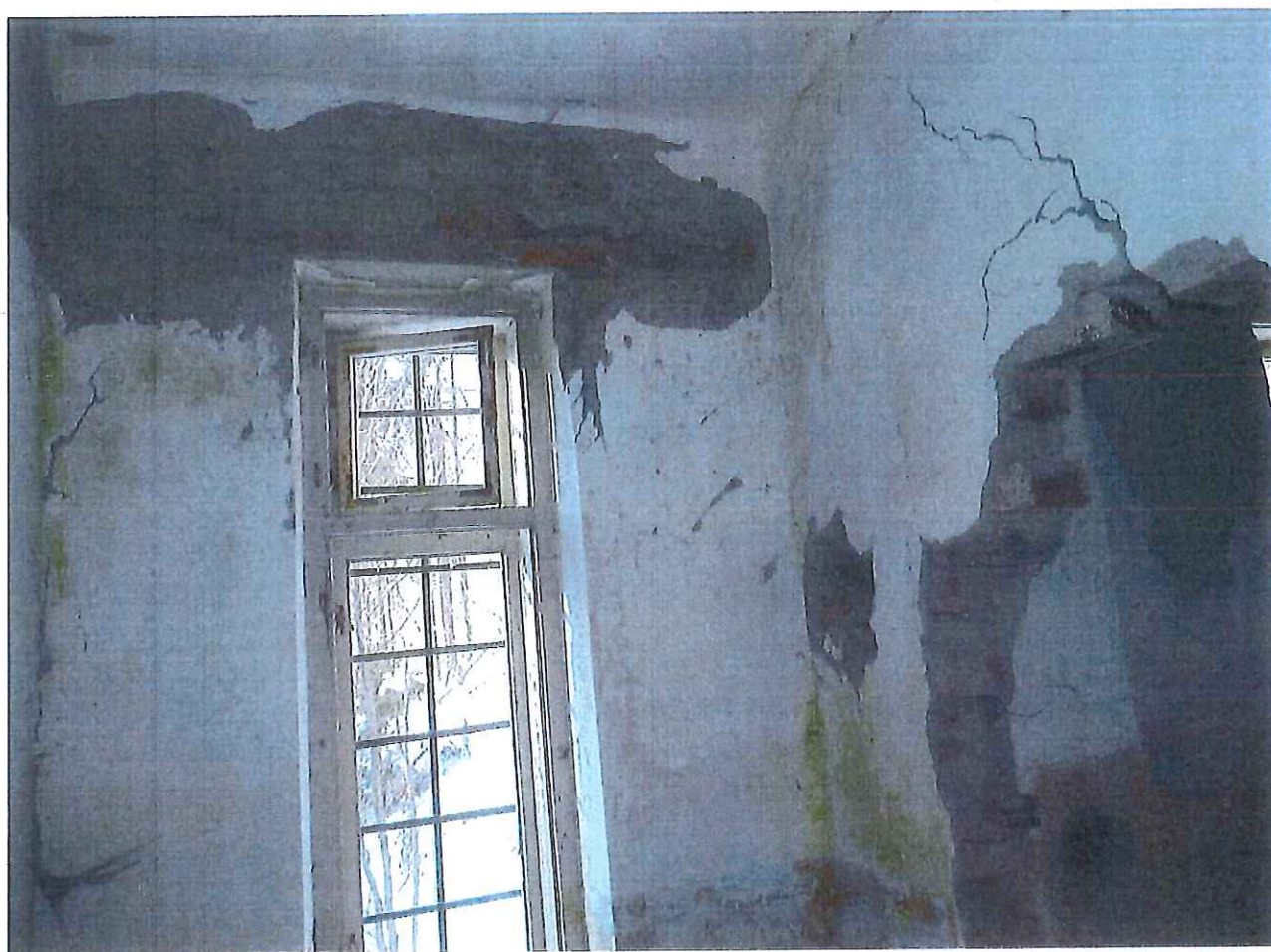
Obz. 6 Poškodenie vnútornej omietky a drevených dverí so kárubňami
