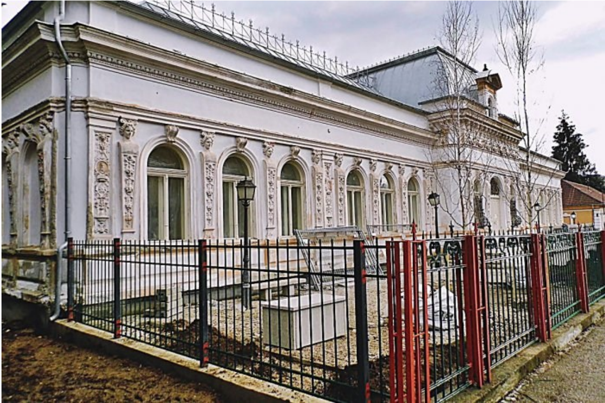
Banické múzeum pred rekonštrukciou.
