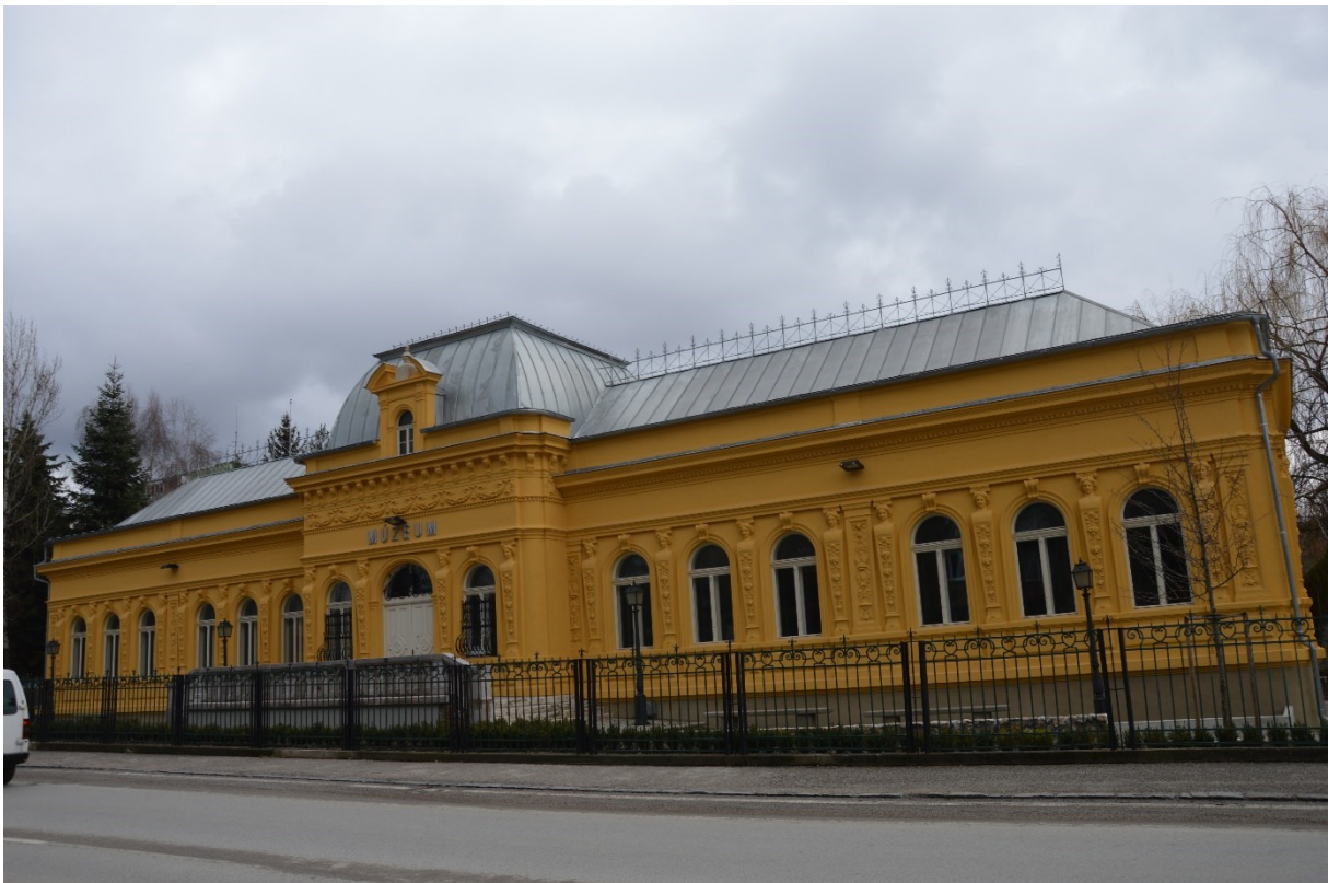
Banické múzeum po rekonštrukcii
